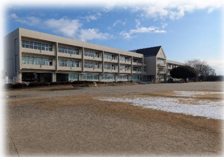
（令和6年度池の上小学校校舎改修工事）
