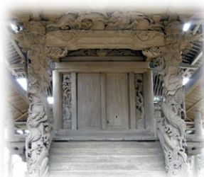
富塚鳥見神社本殿の庇柱
