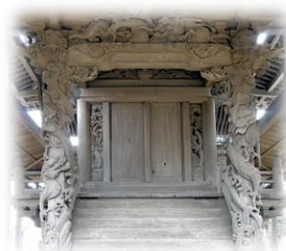
富塚鳥見神社本殿の庇柱
