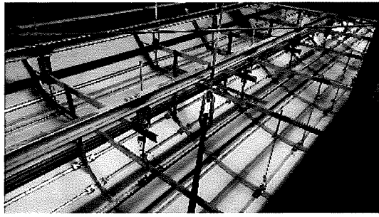
大ホール客席天井裏の吊構造部分
