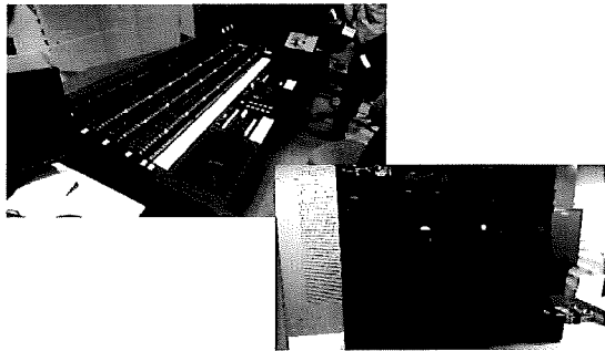
調光卓・音響ラック
