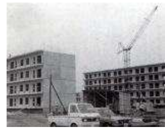
ニュータウン建築工事の様子
