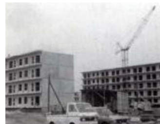
ニュータウンの建設(昭和54年頃)
