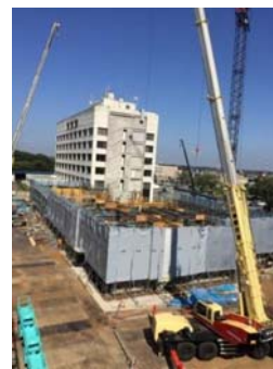
市役所庁舎整備(平成28年)
